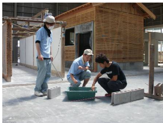
左官・タイル施工科 ブロック積み
